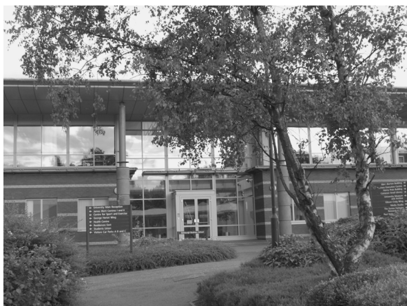
写真1 スポーツセンター正面
