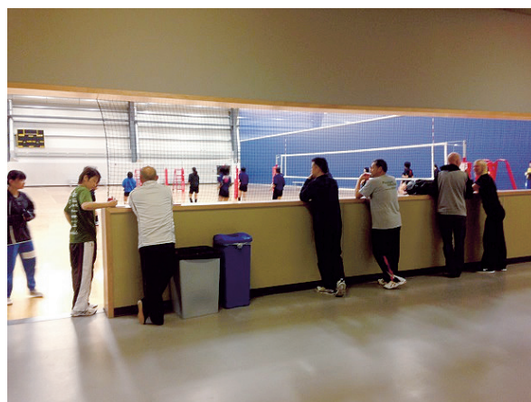
写真3. 廊下と体育館の間に壁や窓はなく吹き抜けになっている
